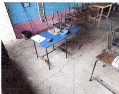
FOTO 4: Sustrucción de piso cerámico
