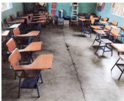
FOTO 3: Sustrucción de piso cerámico
