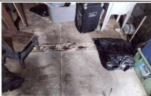
FOTO 5: Sustrucción de piso cerámico
